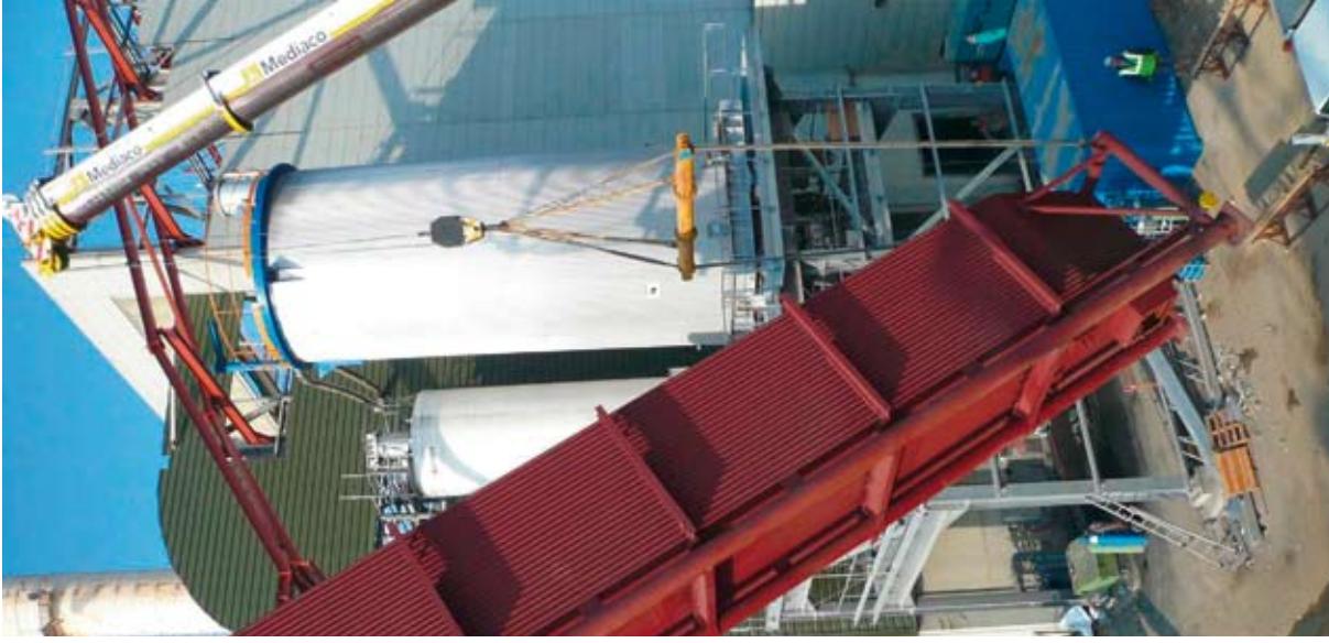
INSTALLATION DE LA CHAUDIERE
