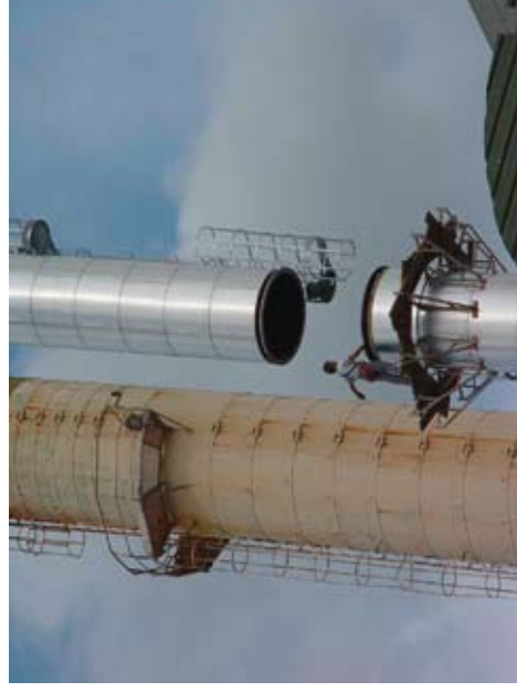
MONTAGE DES NOUVELLES CHEMINÉES
