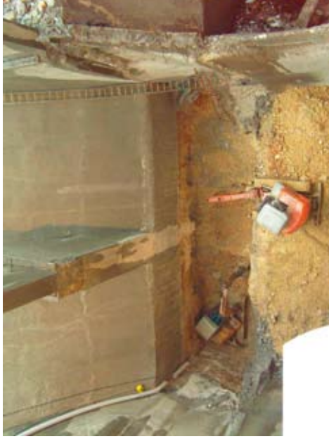
PRÉPARATION DU FOND DE FOSSE
